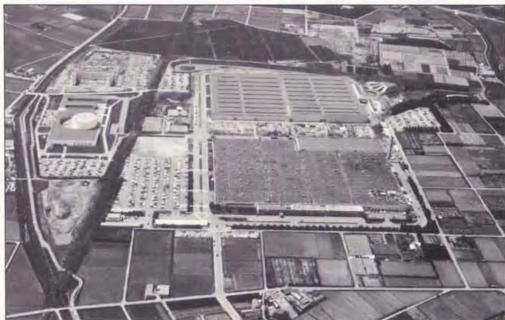
▲FR用オートマチックトランスミッション主力工場 —アイシン・ワナー社本社工場全景
